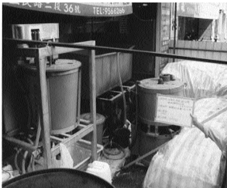
圖1 現場施工機具配置
