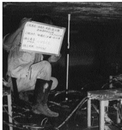
圖9 基礎底部隆起變位計測
