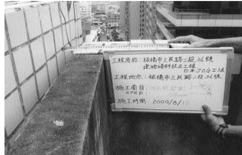
圖17 施工前北鄰 建物間距離 =55mm
