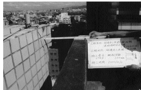
圖18 施工後北鄰 建物間距離 =300mm
