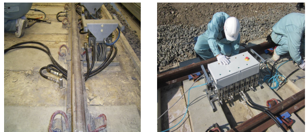
写真-3 ユニットの小型化 (右: 改良後)
