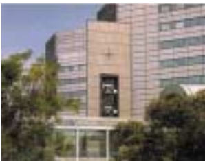
写真-6 修復された時計塔
