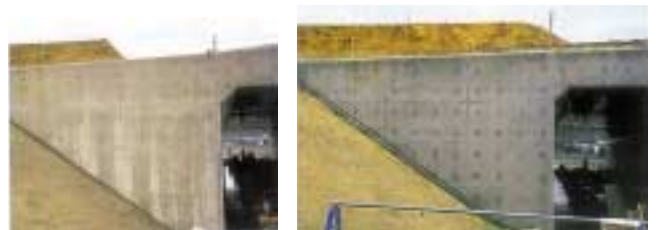
写真-1 施工前のカルバート 写真-2 施工後のカルバート
