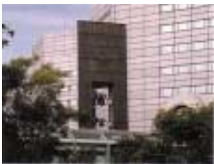
写真-5 地震で傾いた時計塔
