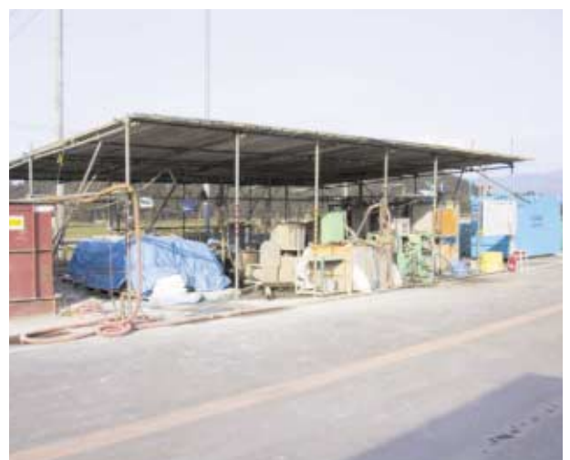
バイパス路側に設置されたプラント
