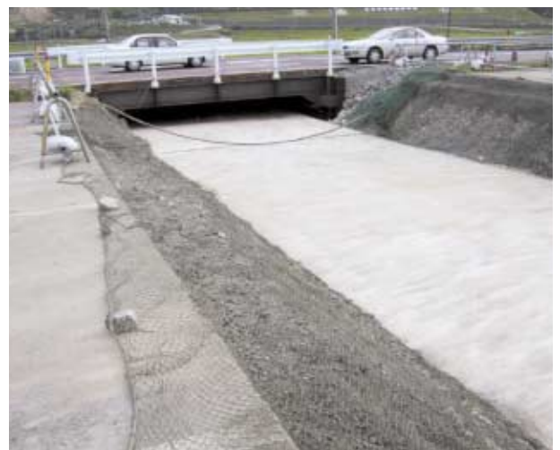
仮橋の下ではボックス復元工事が行われている
